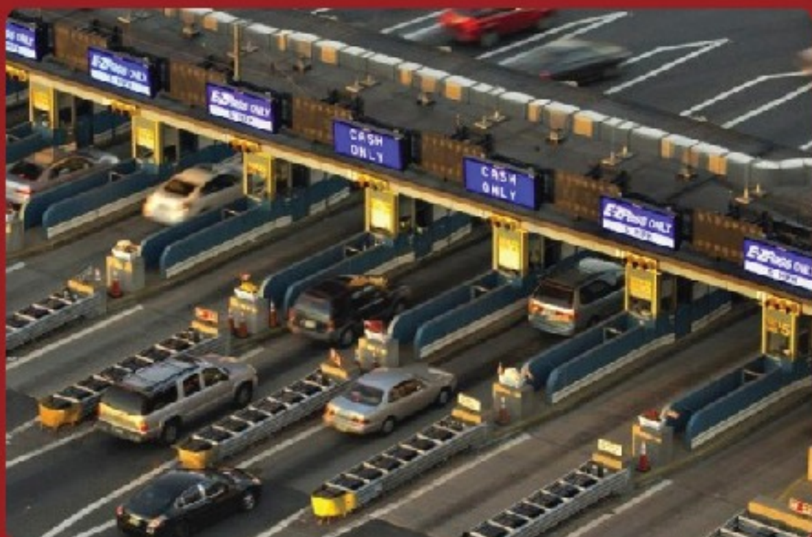
Hệ thống quét laser trong hệ thống thu phí không dừng (Laser scanner system for non-stop toll station projects)
