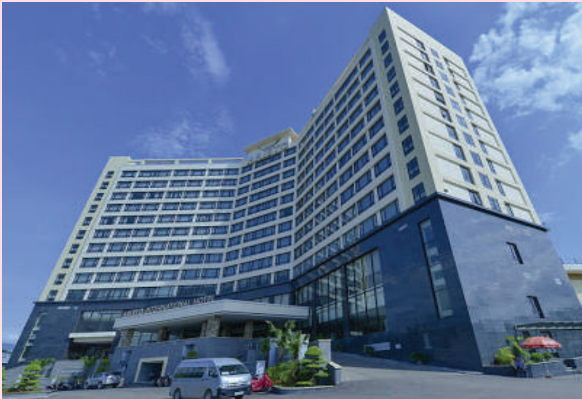
Công trình Khách sạn Quốc tế Lào Cai
