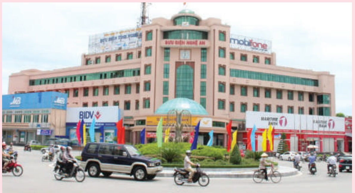
Công trình Bưu điện tỉnh Nghệ An
