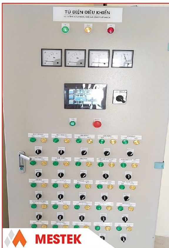
Tủ điều khiển hệ thống transerver lắp ráp ô tô
