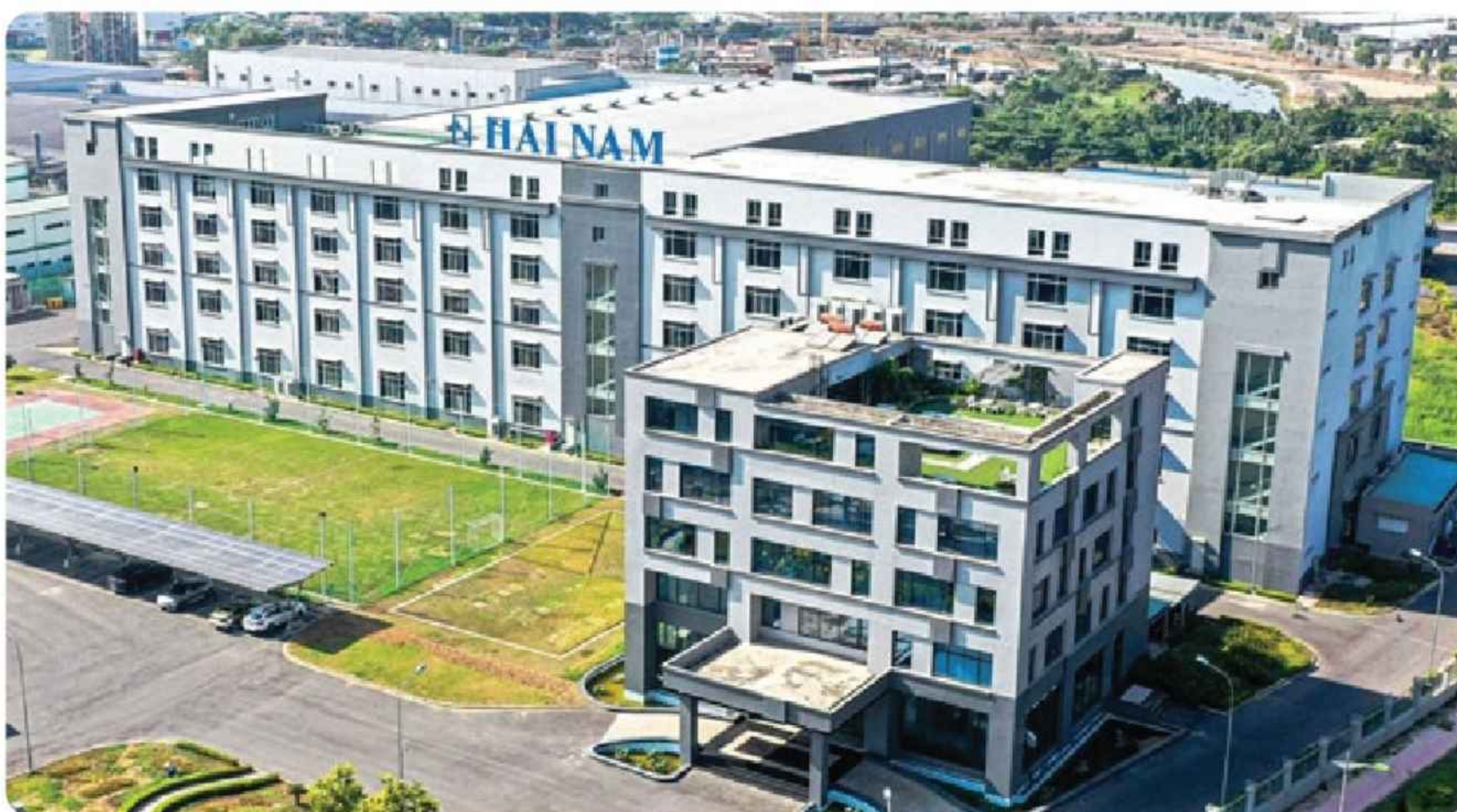
DỰ ÁN: NHÀ MÁY HẢI NAM KHU CÔNG NGHỆ CAO
