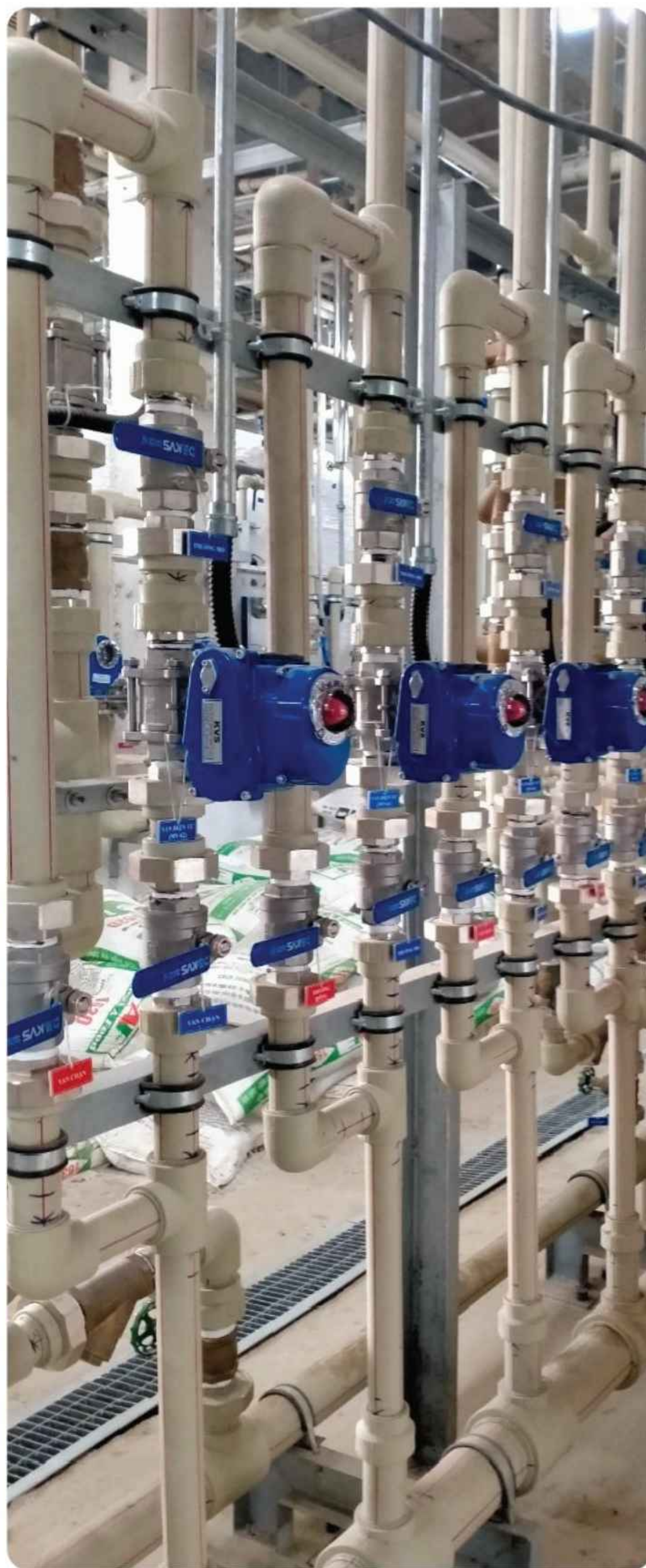
LẮP ĐẶT ỐNG CẤP NƯỚC NÓNG LẠNH
