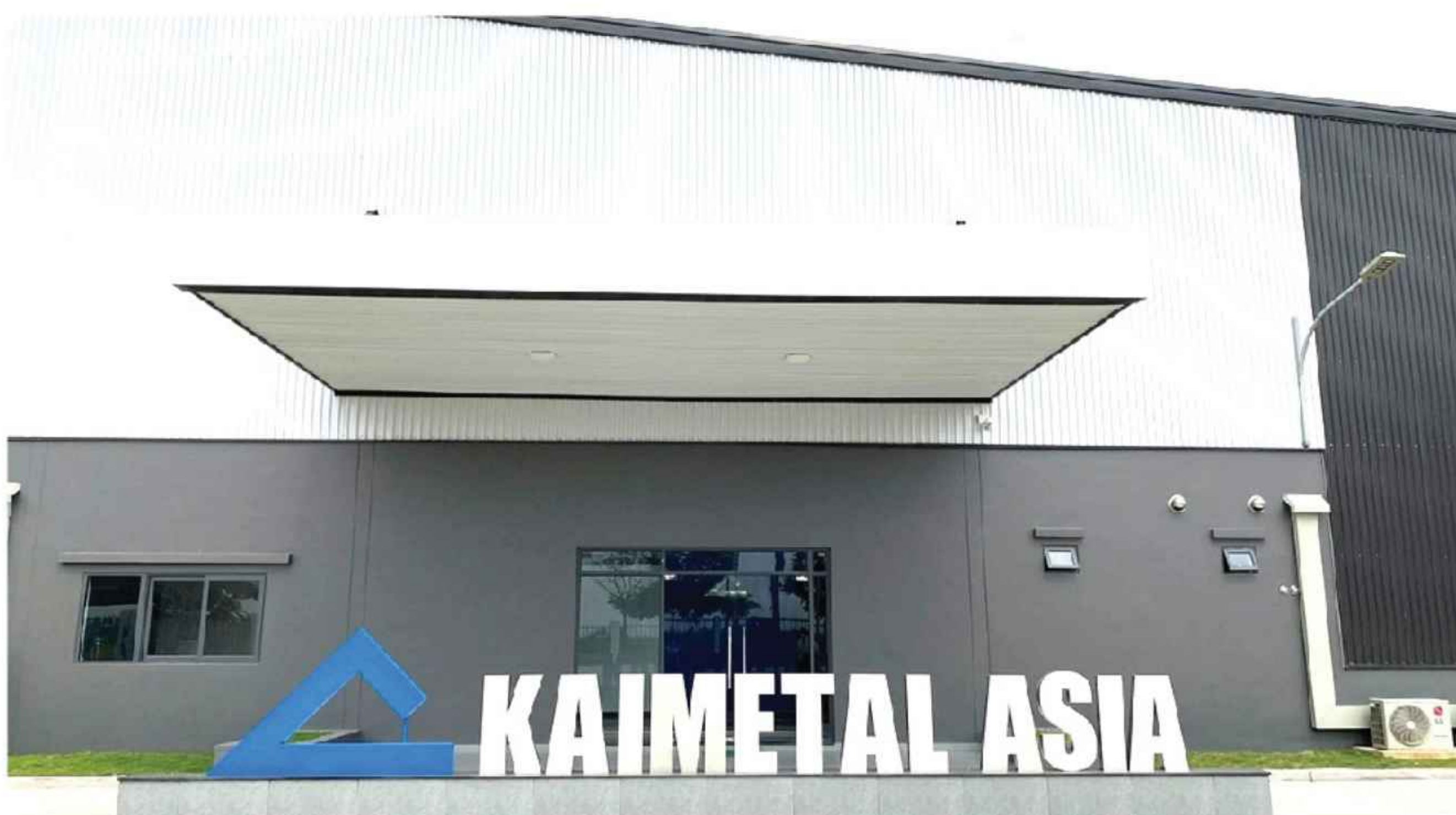
DỰ ÁN: NHÀ MÁY KAI METAL CỦ CHI
